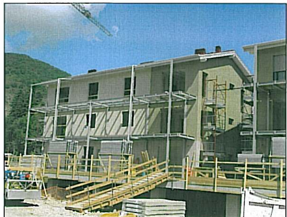
quasi alla fine dei lavori
