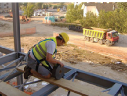
Costruzione delle palazzine in Abruzzo.
